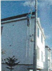
積雪前の屋根のダクト清掃
