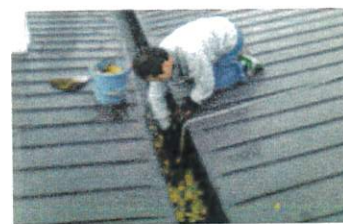
作業は天気の良い日を見計らって、一日二十棟ずつ二人一組で進めました。今期は落葉の時期が例年よりも遅く、神社や公園など樹木の多い地域に近い建物の中には再度、清掃したのももありましたが、予定通りに無事完了。合わせて外壁など建物全体の点検も行いました。
