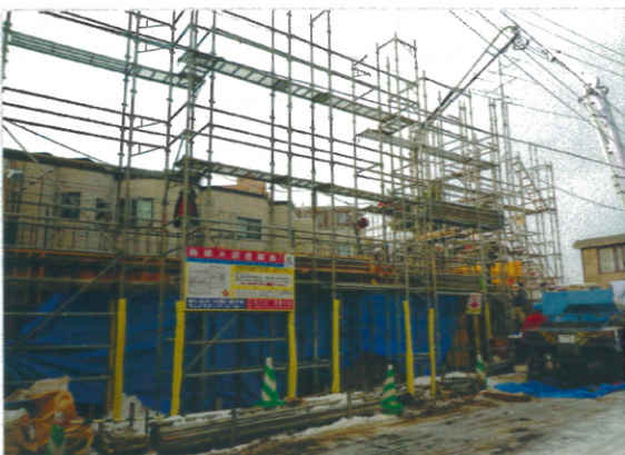
3月の完成に向けて、現在着々と工事が進んでいる
