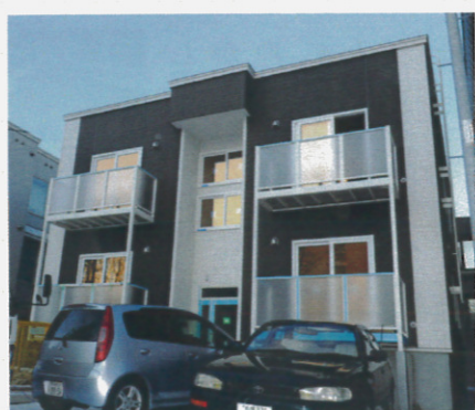
今年1月末に完成予定、西区24軒の建物 木造2階建、地下車庫付き
