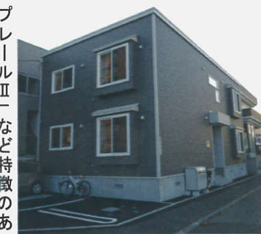
平成24年10月、白石区に完成した「アイリス菊水」
