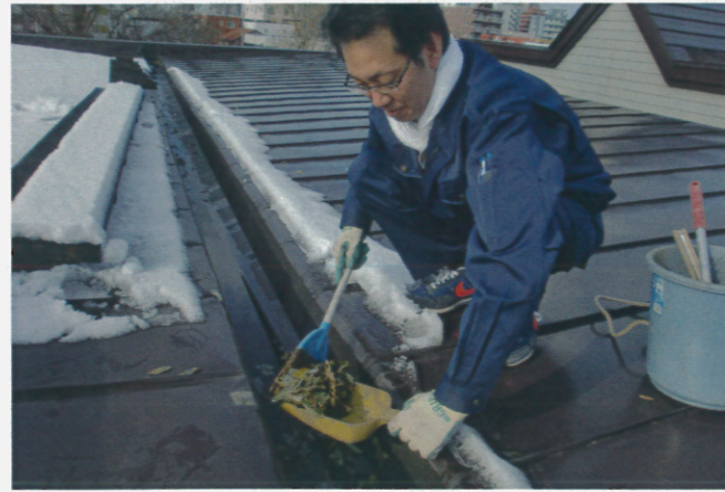
屋根のダクト清掃。 左のように落ち葉でダクトが詰まった状態にしておくくと、水漏れなどの原因になる。
