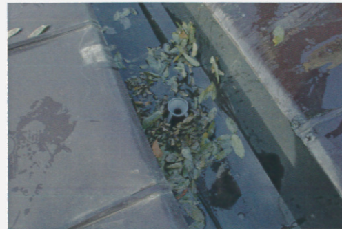
屋根のダクト清掃。 左のように落ち葉でダクトが詰まった状態にしておくくと、水漏れなどの原因になる。
