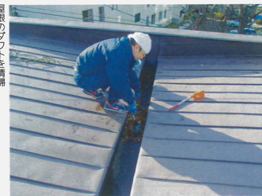
屋根のダクトを清掃
