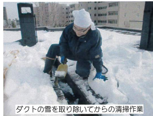
安全に気を配りながら屋根の上へ
