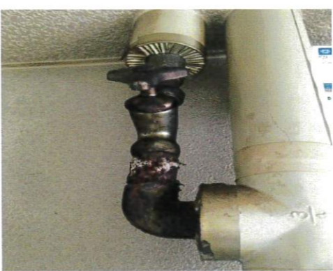
上—つなぎ目に腐食が見られる水道管 左—銅管
