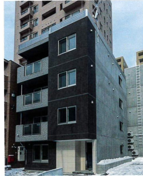
外観はダークブラウンのタイルで重厚にバルコニーにはグレーのタイルを施工
